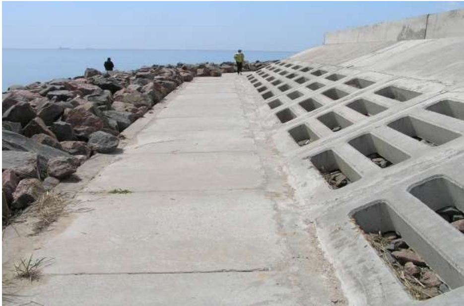
Рис. 3. Надводная часть берегозащитного сооружения (Чабанка)
