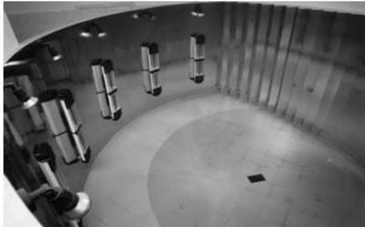
Рис. 5. Камера пелоидотерапии с угловыми и цилиндрическим отражателями
