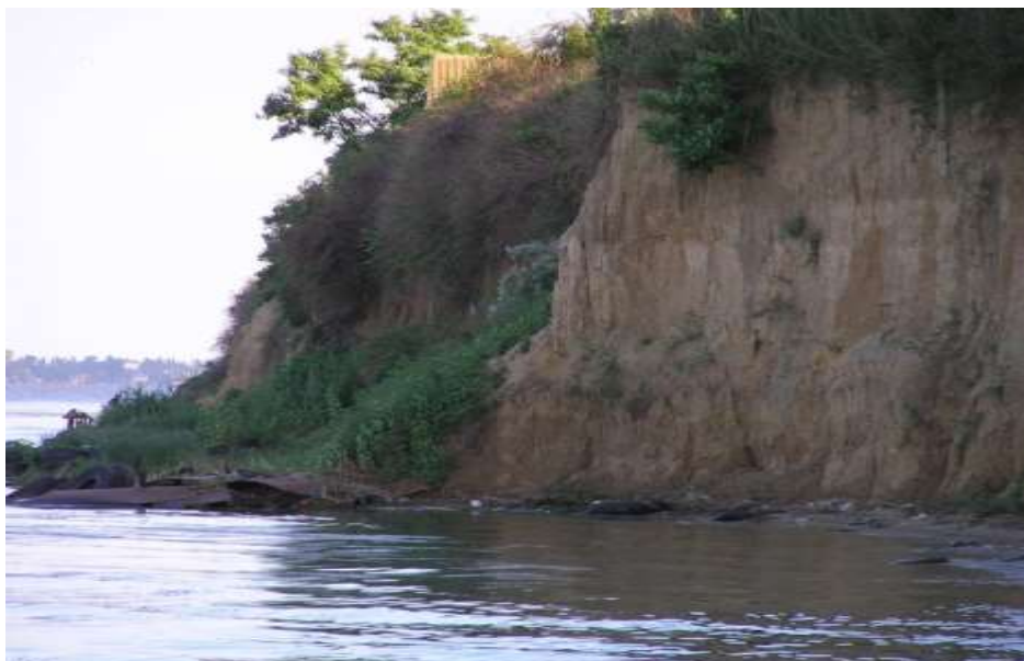
Рис. 4. Состояние берегового склона в черте Шабо
