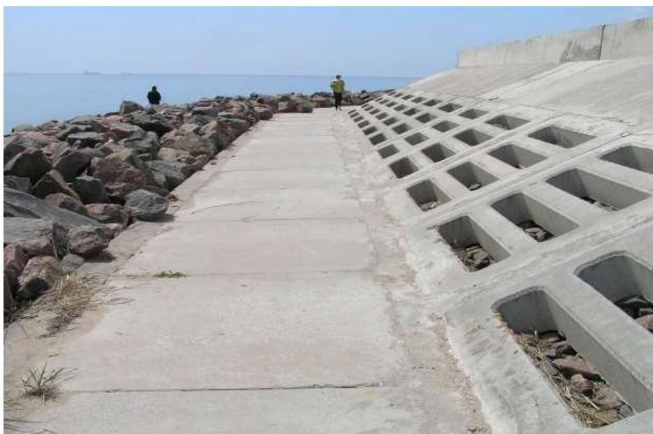
Рис. 3. Надводная часть берегозащитного сооружения (Чабанка)
