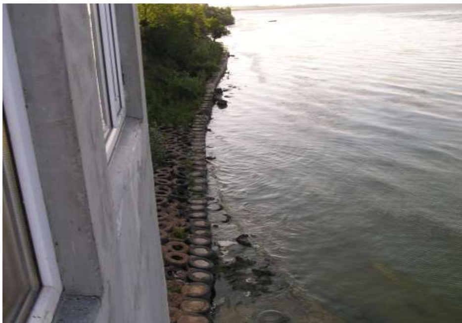
Рис. 5. Локальное укрепление берегового склона в Шабо
